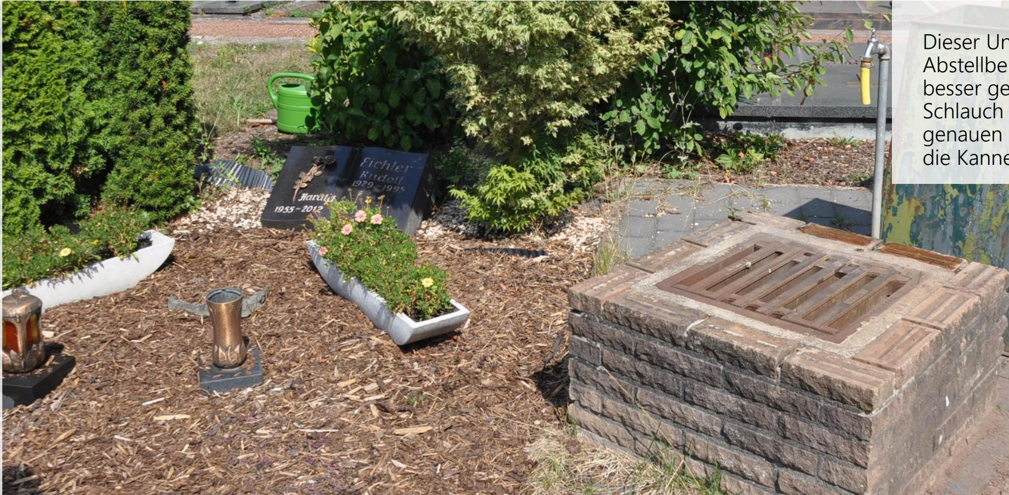
Dieser Unterbau ist als Abstellbereich für Kannen besser geeignet, der Schlauch hilft beim genauen Wasserzapfen in die Kanne.
