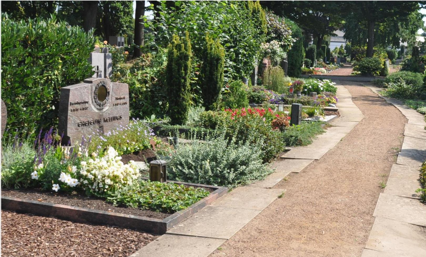
Die Verwerfungen der Platten zeigen deutlich, warum in Sarggrabbereichen wassergebundene Oberflächen sinnvoller sind: Auch wenn sie nachsacken, entstehen keine Stolperkanten, zudem können sie verhältnismäßig leicht nachgerichtet werden.
