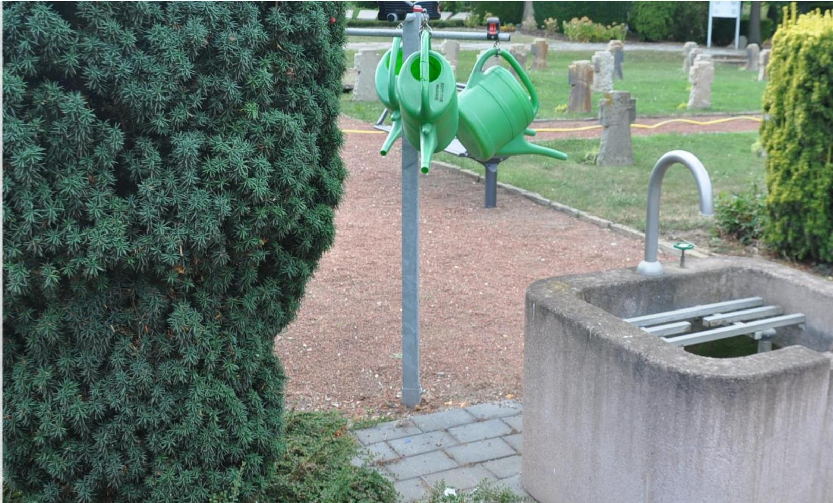
Wasserstellen sollten immer das Wasserzapfen mit einer Abstellinrichtung ergonomisch passender Höhe ermöglichen. Bei diesem Modell ist die Kombination mit einem Schöpfbecken gelungen, der Abstellrost liegt jedoch zu hoch, die volle Kanne muss über einen Rand hinweggehoben werden.
