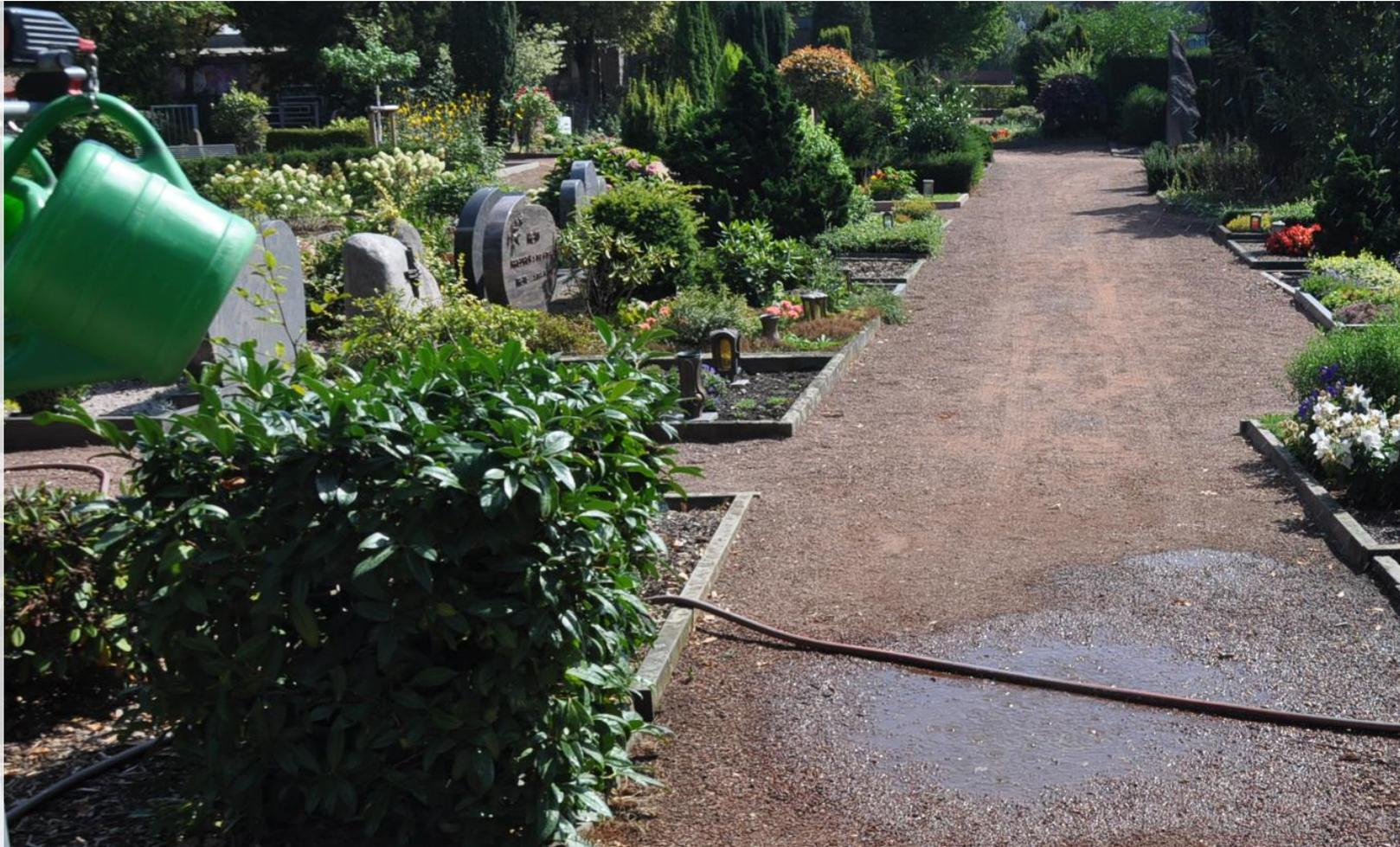
Die wassergebundene Decke der Friedhofswege ist in einem guten Pflegezustand. Die Deckschicht enthält ggf. zu viele Feinteile und ist sehr weich, die Splittabstreu hat sich ungleichmäßig an die Ränder verteilt, sodass die Splittschicht dort zu dick ist. Dies ist für Rollatoren und Rollstühle schwerer zu begehen.
