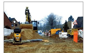
Abbildung: Im 1. Bauabschnitt bereiten Bagger die Bettung für die neue Fahrbahn vor.
